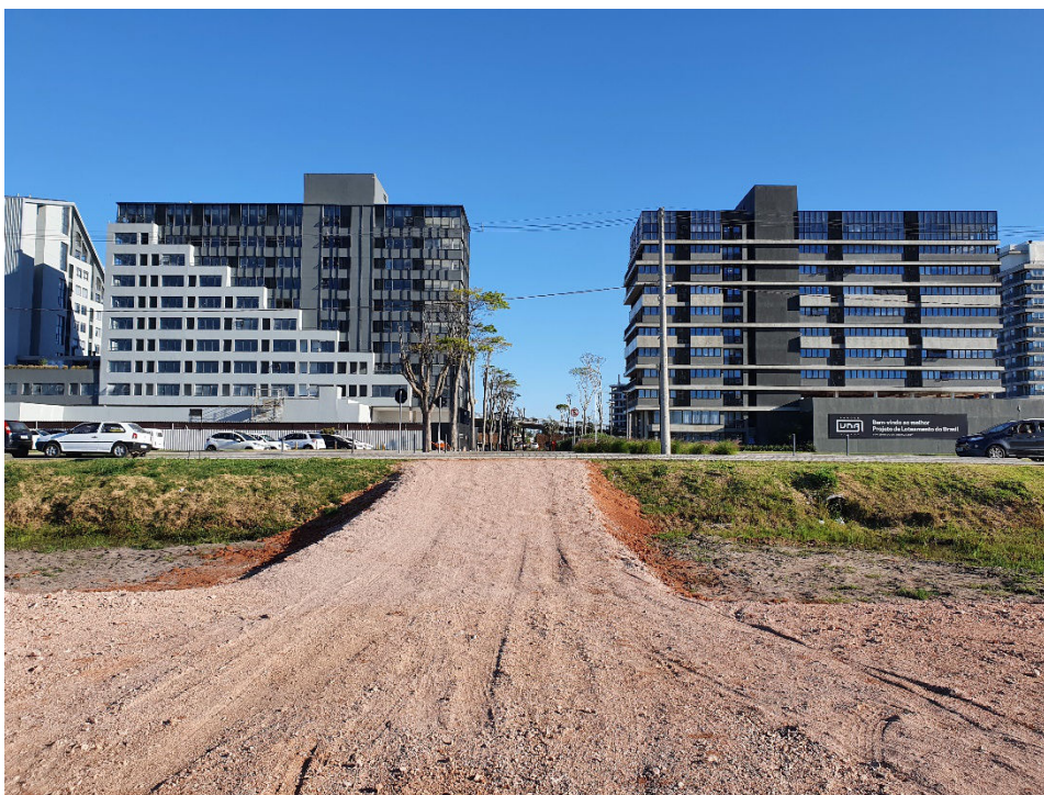
FOTO 02: TERRENO E ENTORNO IMEDIATO
